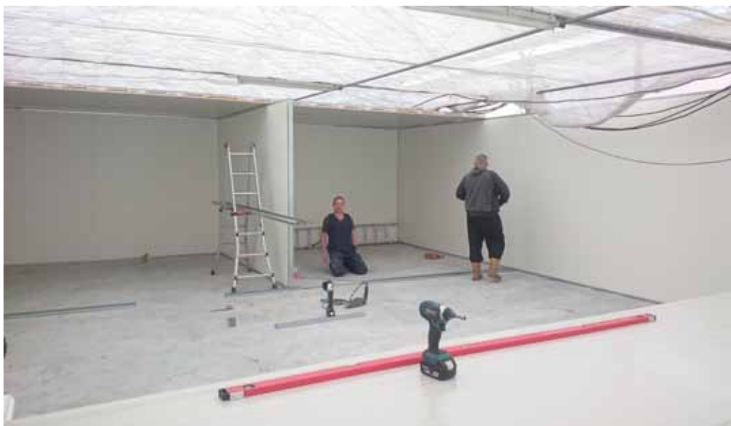
Bollaart helpt mee met de aanleg van de werkruimte.
