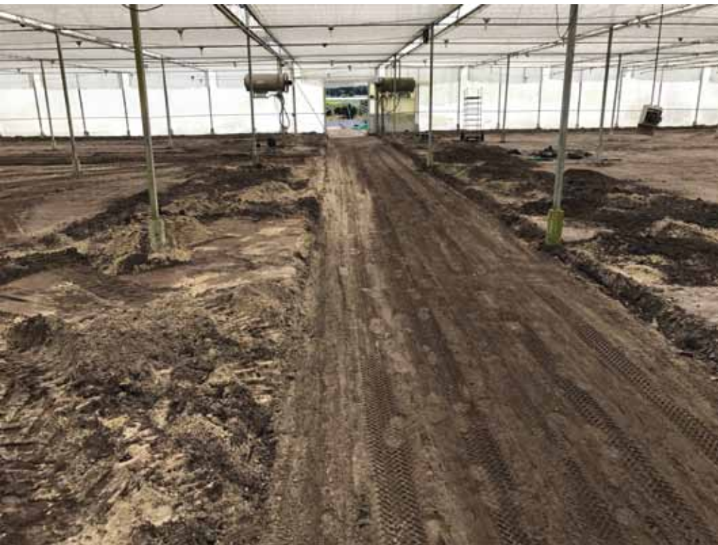
Aanleg nieuwe teeltvloer.
