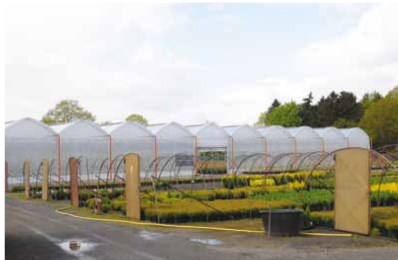
Op de voorgrond nog een aantal 'ouderwetse' tunnels voor winterbescherming; op de achtergrond de nieuwe kas uit 2014 met gotische gevels.
