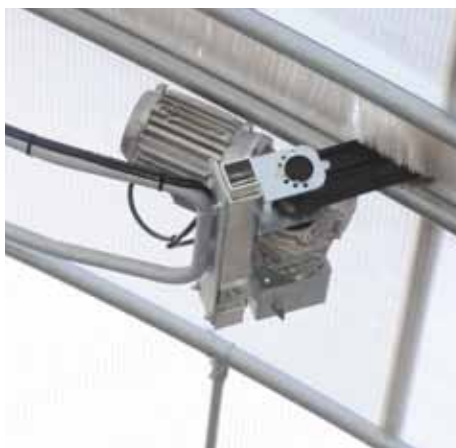
Deze motoren drijven lange aluminium rolbuizen aan, die over de complete lengte van de kas het foliedoek oprollen
