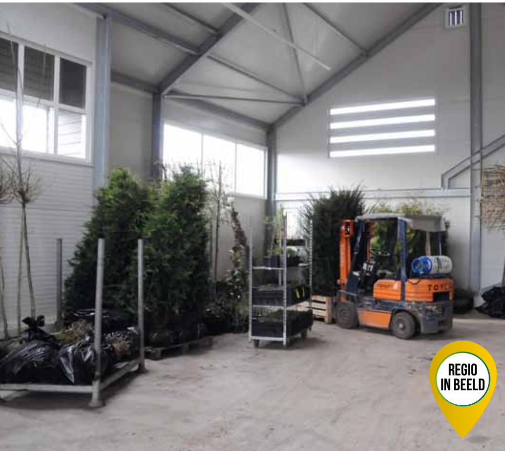
Ruime en lichte loods met muurbekleding van damwandplaten.
