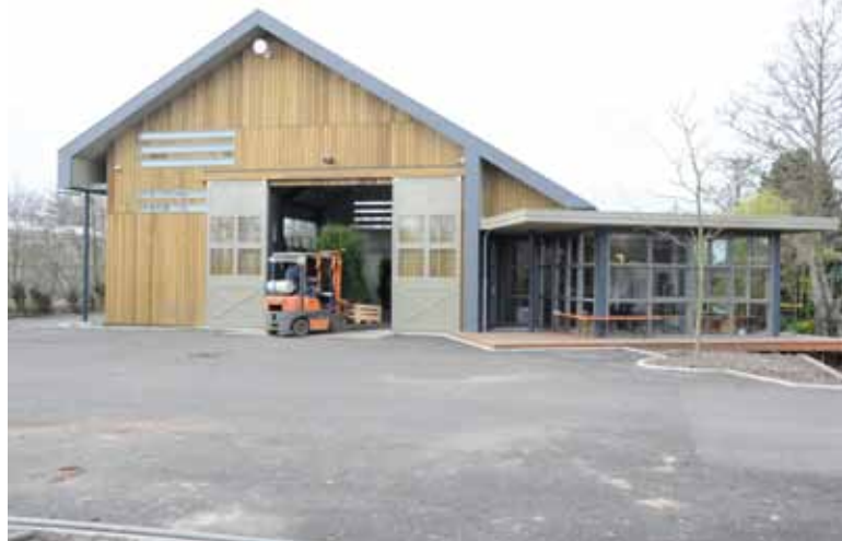
Achterzijde van het nieuwe pand.
